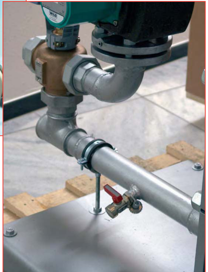
Primärseitiges Entleerungsventil
