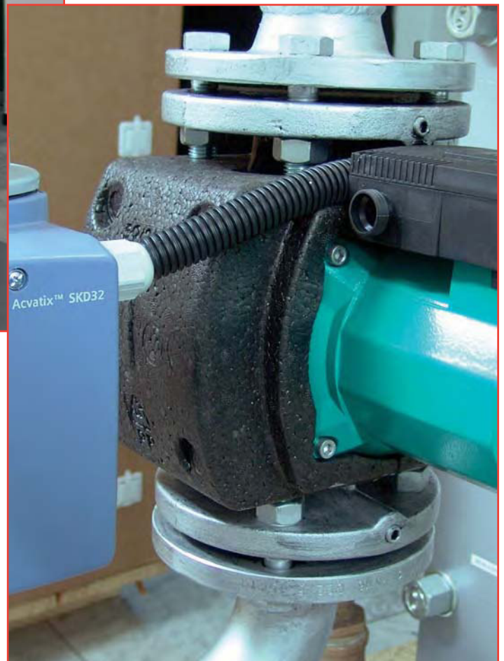
Verflanschte Primärpumpe
