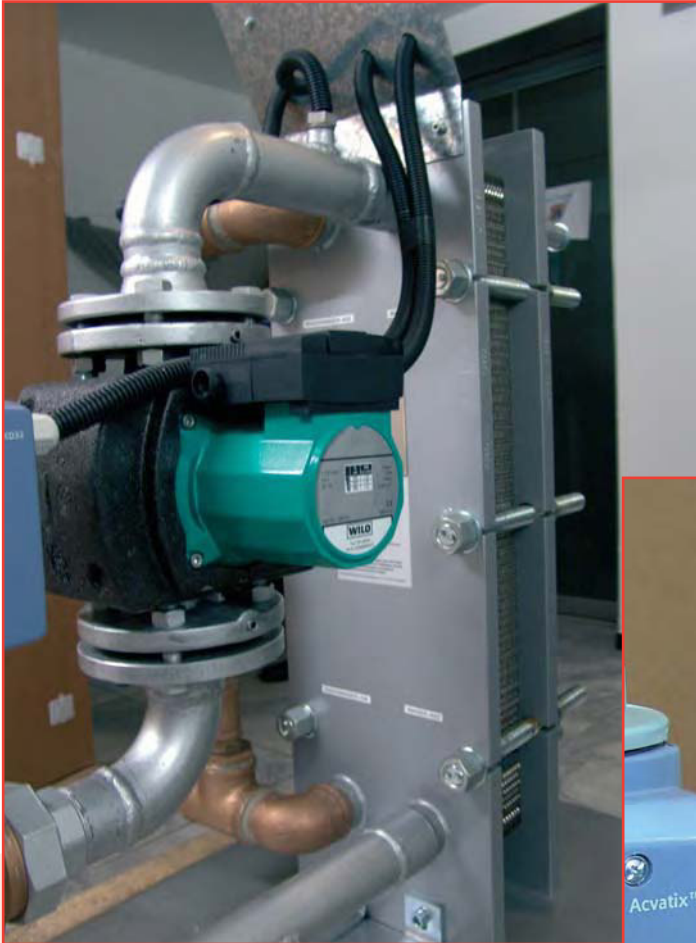
Primärpumpe, Sekundär Ein- und Ausgang in Rotguß
